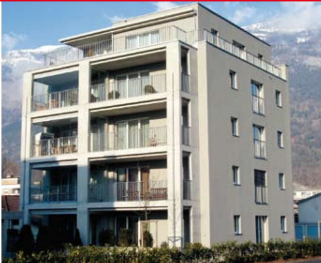
Mehrfamilienhaus an der Scalettastrasse in Chur.
