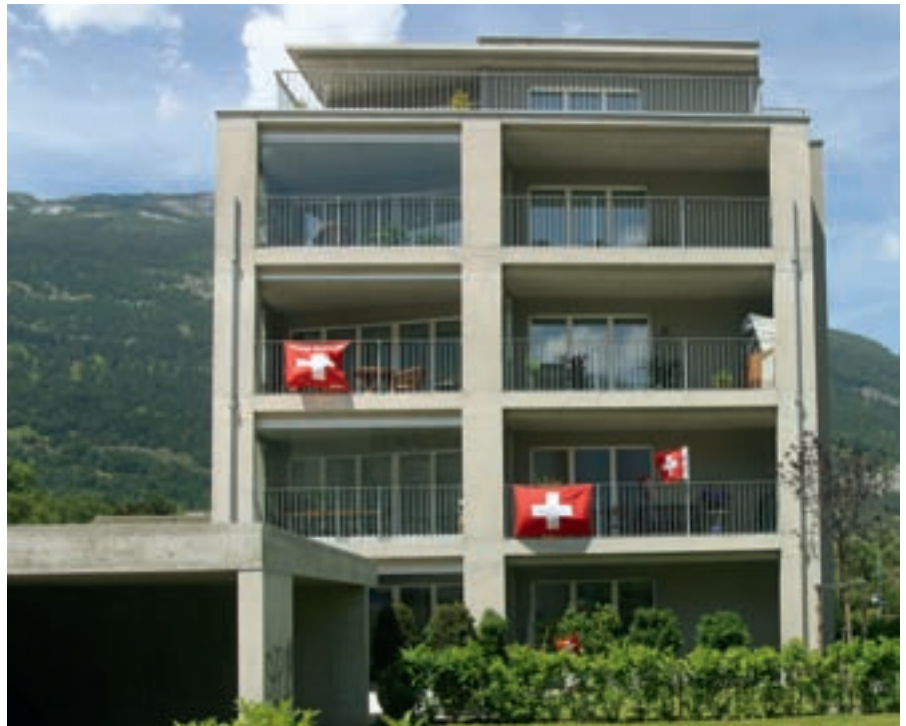
Mehrfamilienhaus an der Scalettastrasse in Chur, gebaut als Passivhaus
