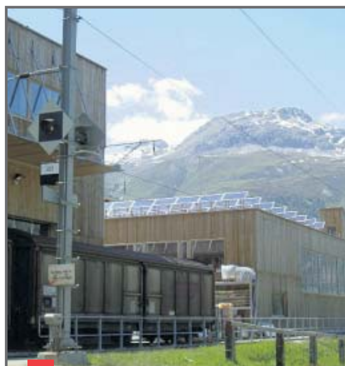
La maison passive à Punt Muragl est munie de panneaux photovoltaïques et profite des nombreuses journées ensoleillées de l'Engadine.
